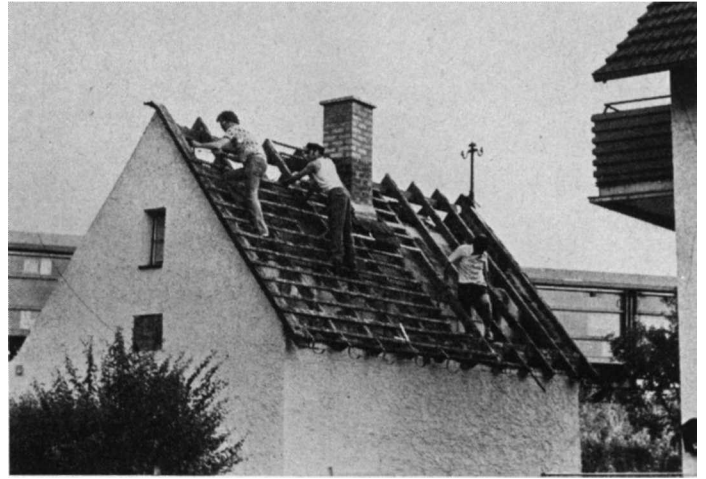
DIE RESERVISTEN DER RK SINGEN beim Umbau ihres neuen Heimes (von links): Fw d. R. Baldauf, HptGefr d. R. Mai, HptGefr d. R. Wessner.
